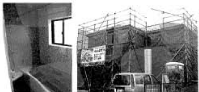
10月初旬 サイディング工事が完了し、現在は室内木工事、浴室やキッチン等の設置工事が始まりました。11月初旬には完成予定です。N様にお引渡しをさせていただく前に完成した建物を内覧いただける機会をご用意する予定です。お気軽にご参加ください。
