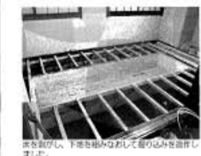
床を張り直し、下地を補修しながら掘り込みを造作しました。
