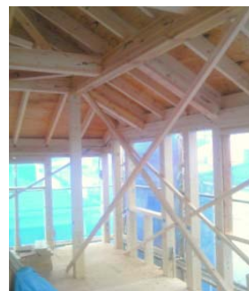
上棟後(3階部分)
