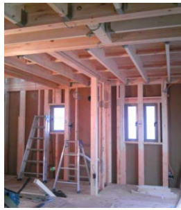
大工工事中 (リビング・ダイニング)
