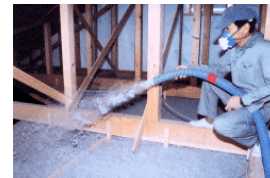
天井への吹込み施工
