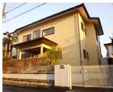
外壁は淡いクリーム色に塗り替えてイメージチェンジ。雨樋の交換工事も行いました。
