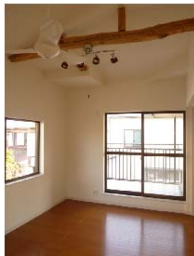
梁をあらわにして勾配天井に仕上げています。
