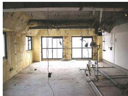
内部の解体を行いスケルトン(骨組み)状態
