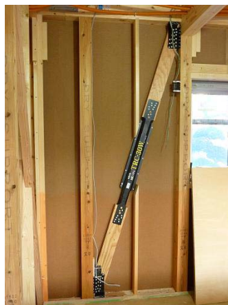
S様邸に取り付けた制震ダンパー
