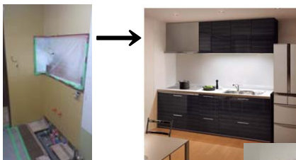
↑キッチン解体後 食洗機付に変更
