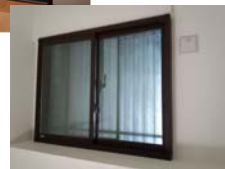
断熱内窓工事→
