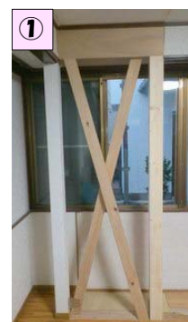
①H様邸で行なった筋交い工法補強。 ②制震ダンパーは地震の変形を最大60%軽減します。(事務所展示品)
