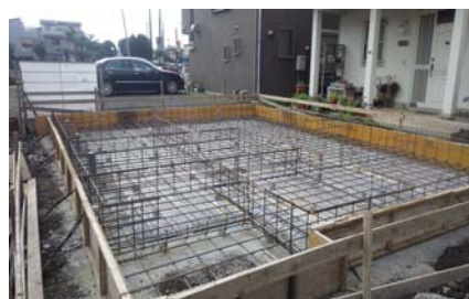
6/7 基礎工事着工しました
