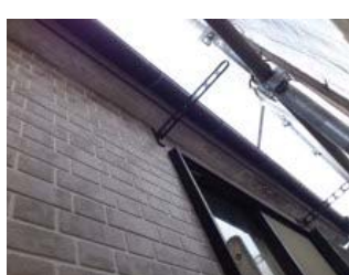
④外壁を貼り直し、すべての外壁のシーリングを打替え及び増打ちをしました。
