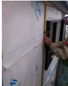
③外側に防水シートを貼って、二重防水処理をしました。
