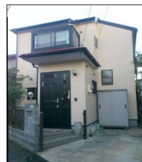
⑥外壁塗り替え後明るく変身しました。
