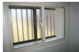
☆内側に高性能窓を設置☆
