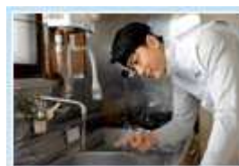
水廻りの通水確認
