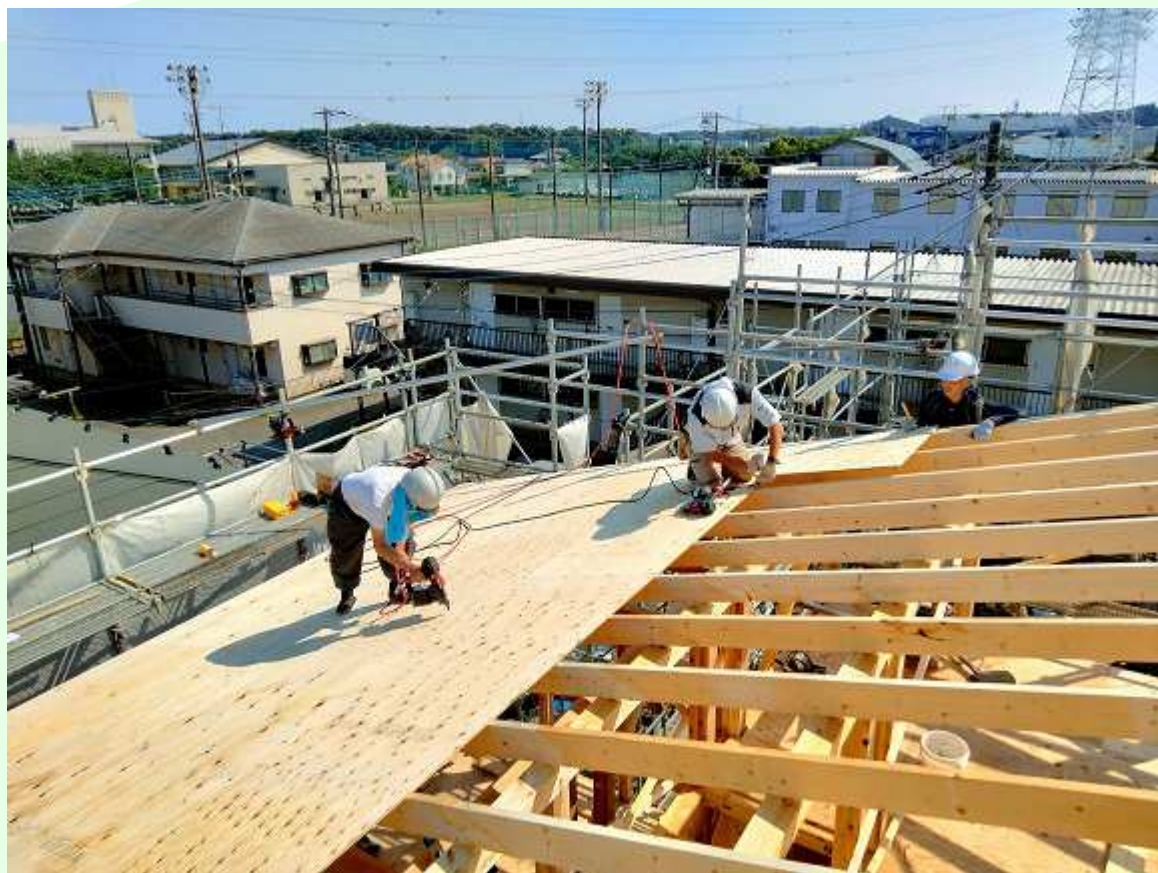
綾瀬市吉岡東新築A棟・B棟 7月に上棟しました
