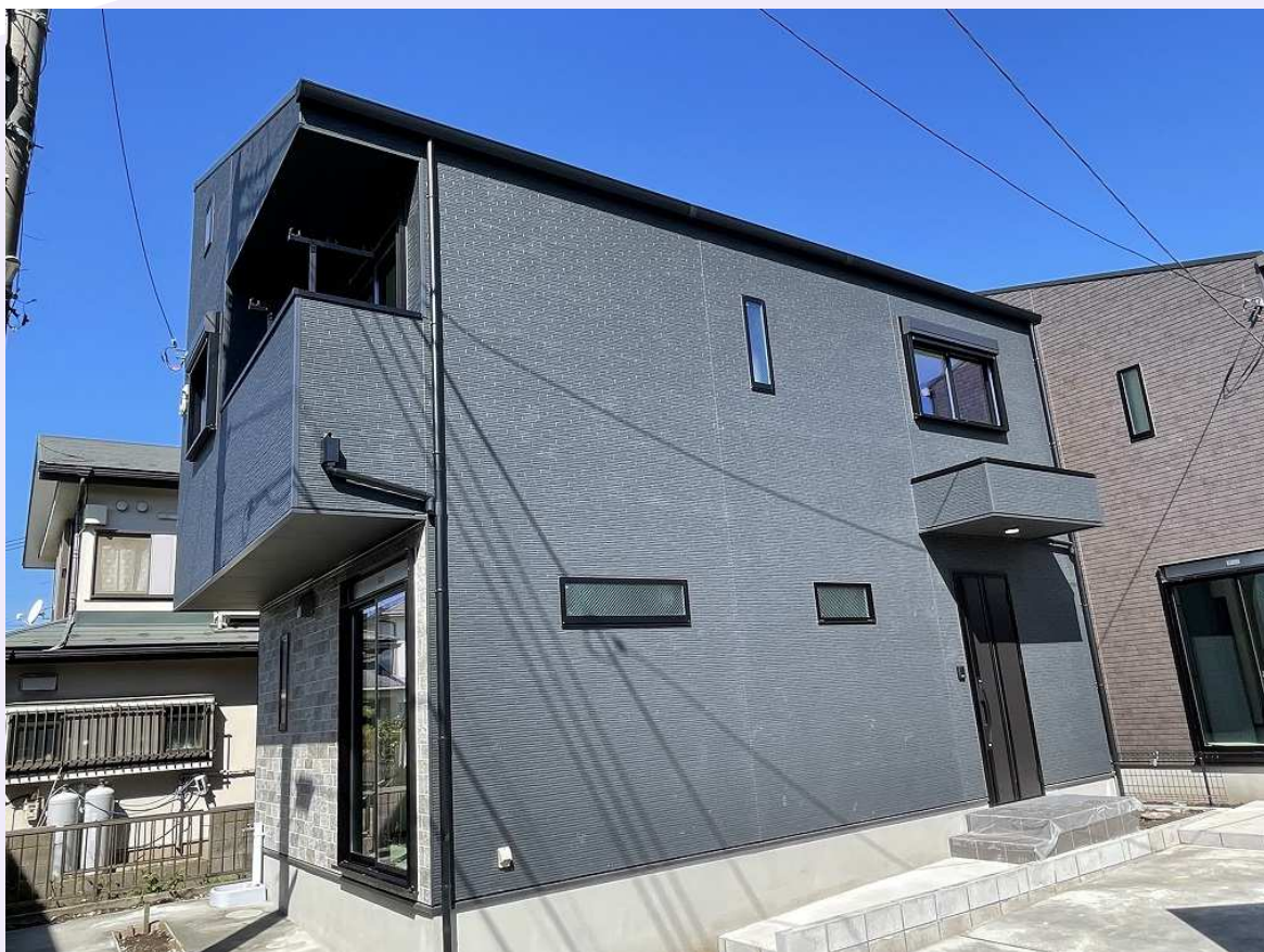
綾瀬市吉岡東新築A棟・B棟完成しました。
