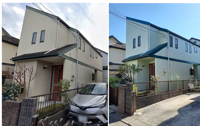
大和市K様宅の外壁塗装（2023年4月完了）
