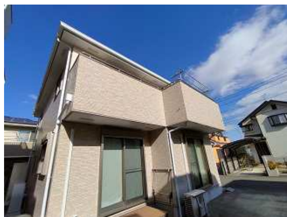
町田市O様邸外壁塗装（クリア塗装）
