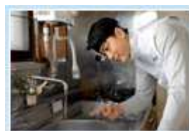
水廻りの通水確認
