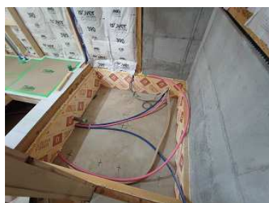
断熱材の施工や給排水も確認できます
