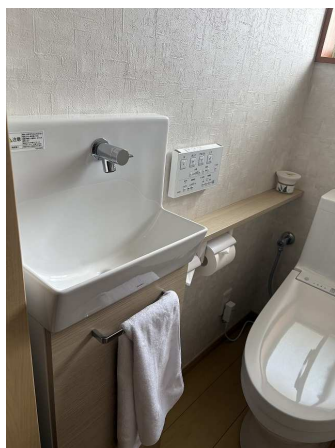
↑トイレは清潔に保てるよう吐水口を無くして手洗器を新たに設置しました
