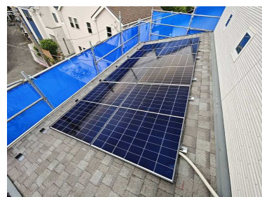
自宅の北側と南側屋根に太陽光パネル2.64kwずつ、室内に蓄電池10kwとハイブリッドインバーター10kwを設置しました。
